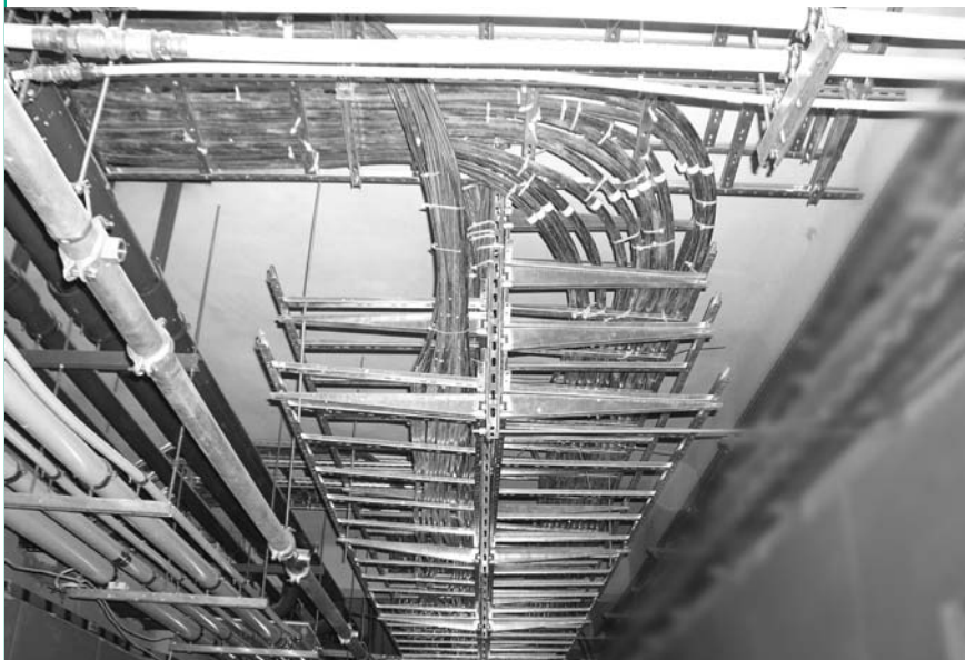
Przykład montażu Drabin kablowych przy użyciu Wspornika WPCW i Wisięgników WSZ
