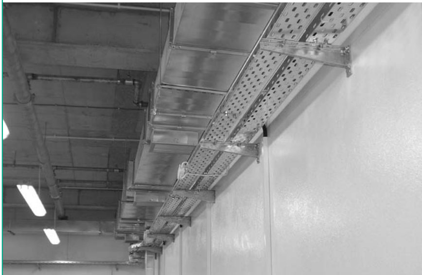
Przykład montażu Drabin kablowych przy użyciu Wspornika WPCW i Wisięgników WSZ
